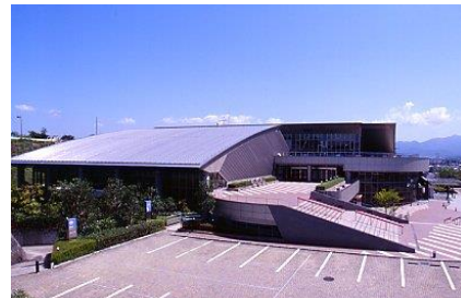
総合西市民プール
